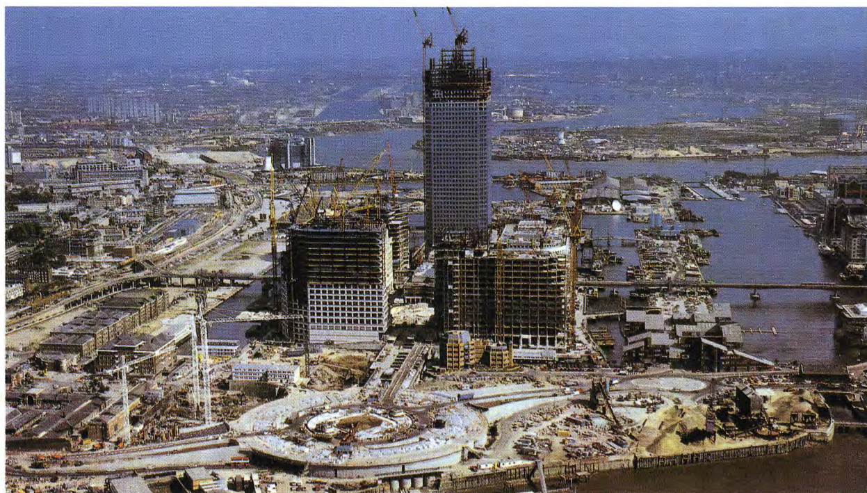
Fig. 6. Canary Wharf en construcción.
